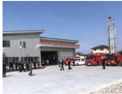
50号の拡幅により城南消防署も移転
